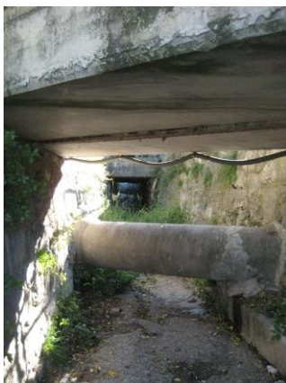
Figura . 1 - Restringimento della sezione di deflusso Valle della Ruina e Valle Berton
