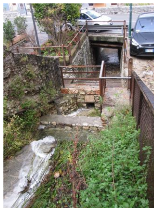
Figura . 1 - Restringimento della sezione di deflusso Valle della Ruina e Valle Berton
