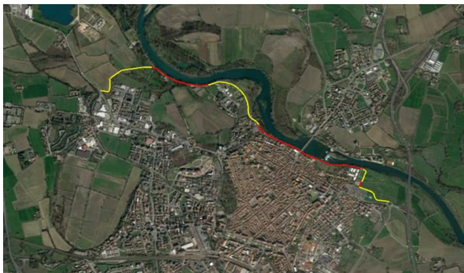
Figura 1 – Foto area della città di Lodi con identificazione del tracciato del sistema arginale realizzato in destra idrografica. In giallo sono indicati i tratti in terrapieno, mentre in rosso sono indicati i tratti in calcestruzzo armato
