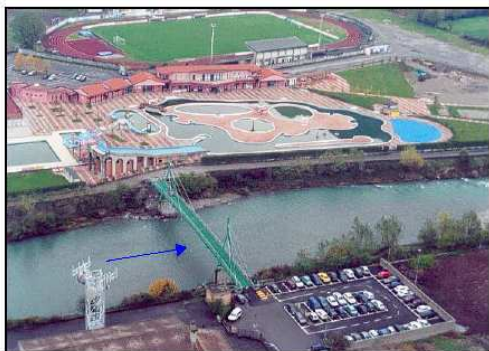
Fig. 21 - Passerella pedonale, costruita nel 1980, che mette in comunicazione la frazione di Corna (in sponda destra) con gli impianti sportivi di recente costruzione.
