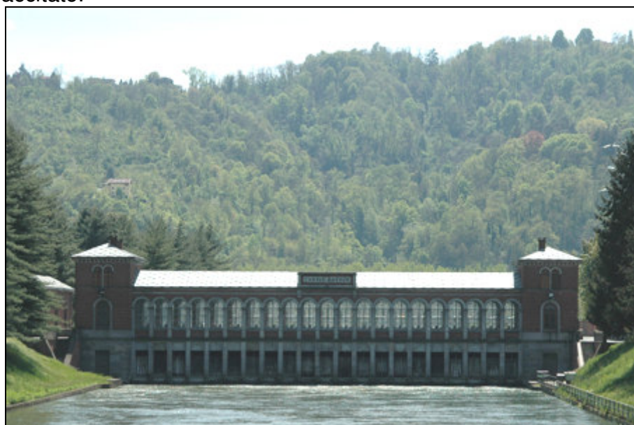
Foto 1 – Opera di presa Canale Cavour
