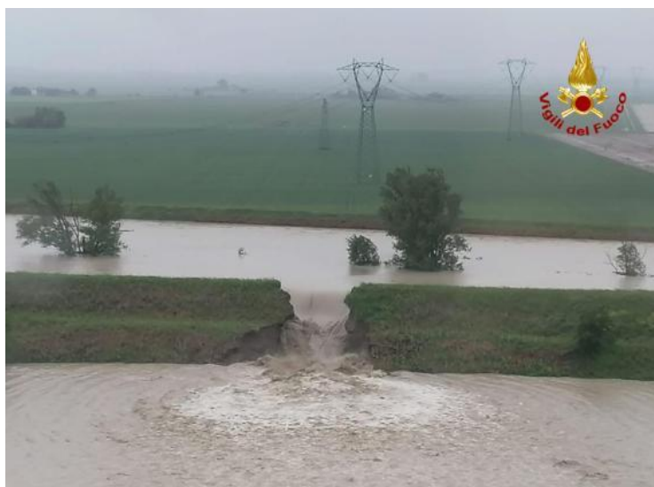
Figura 5 Rotta arginale del torrente Sillaro
