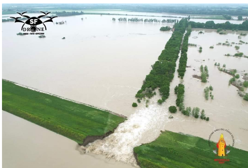
Figura 4 Rotta arginale del torrente Quaderna
