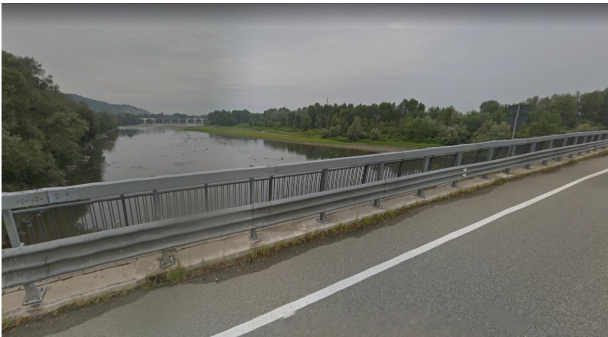
Figura 4. Vista dal ponte di "Verolengo" (TO) sulla SP 94
