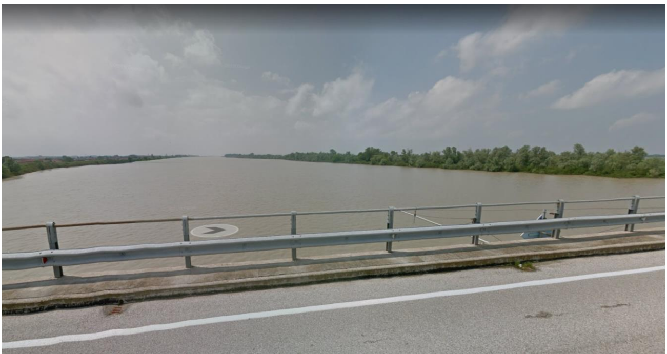
Figura 12. Vista dal ponte di "Porto Tolle" (RO)
