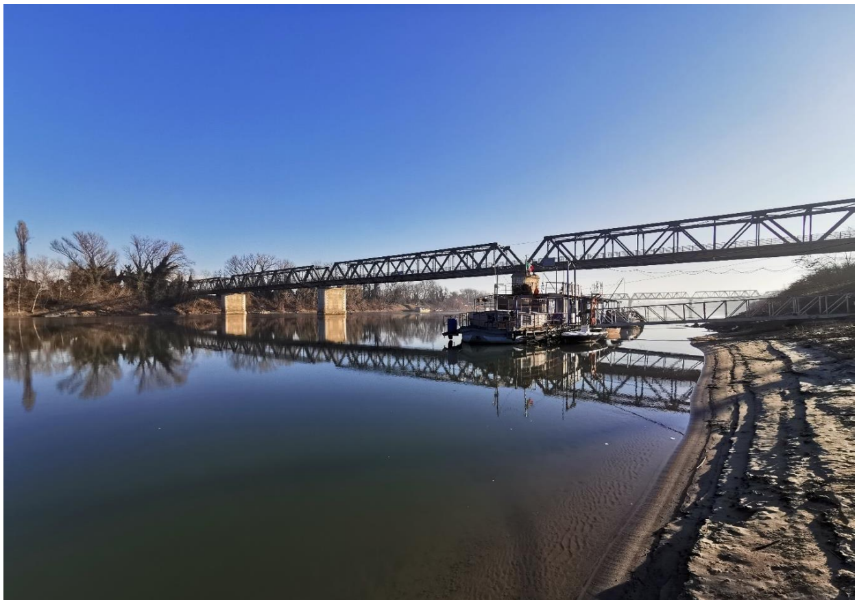
Figura 10. Vista del ponte di "Pontelagoscuro" (FE) sulla SS16
