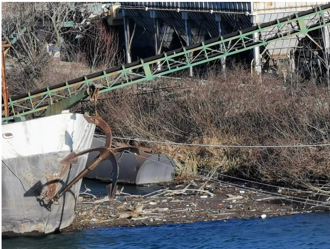
Figura 29. Accumulo di detriti di varia natura lungo le rive a valle del ponte di Isola Serafini
