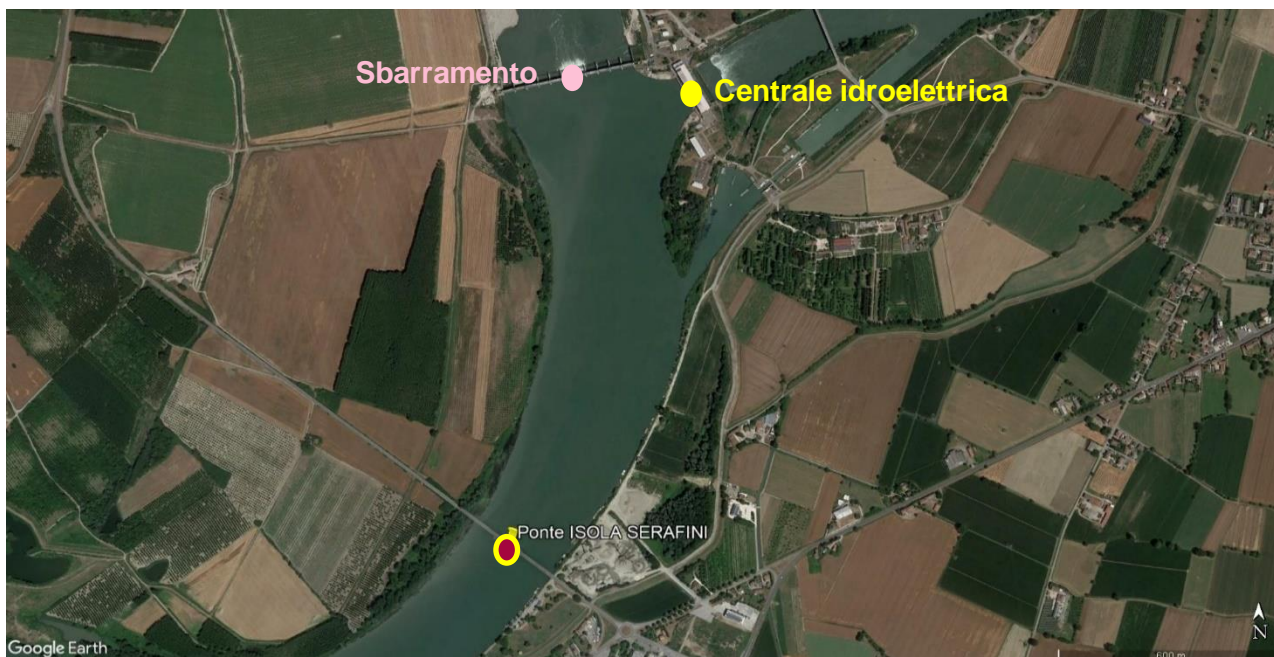
Figura 63 - Ponte di Isola Serafini, sbarramento lungo il fiume Po e centrale Idroelettrica
